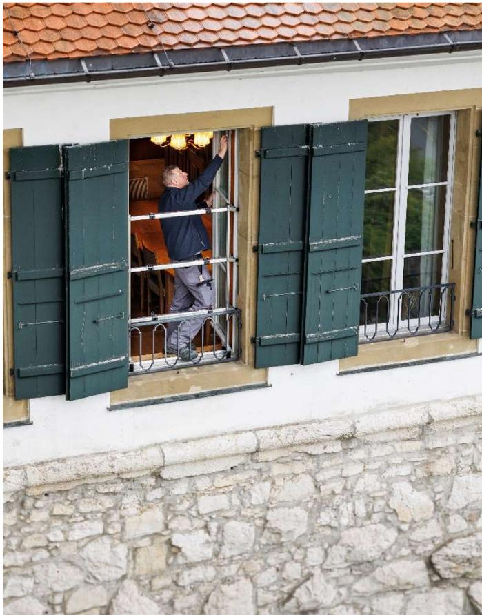
Auch für etwas höhere Fenster, gibt es eine Lösung mit einer zusätzlichen Querstrebe, damit man trotzdem sicher arbeiten kann (Bild)
